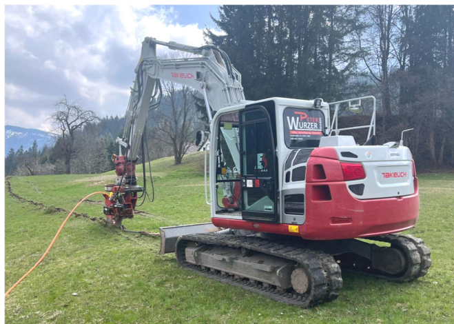
Firma Peter Würzer GmbH bei der Leitungsverlegung zu den Liegenschaften Pöllenreith 1 und 2.
